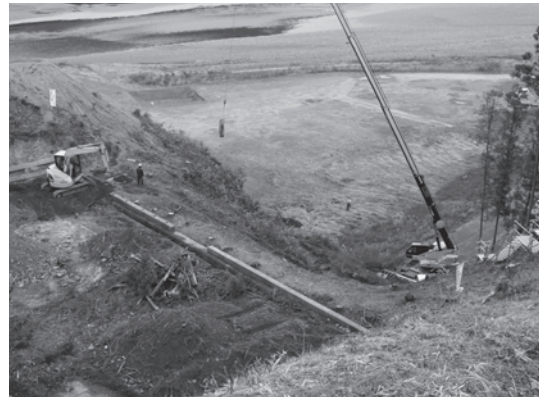
挿写真9 クレーン車による土砂搬出作業
