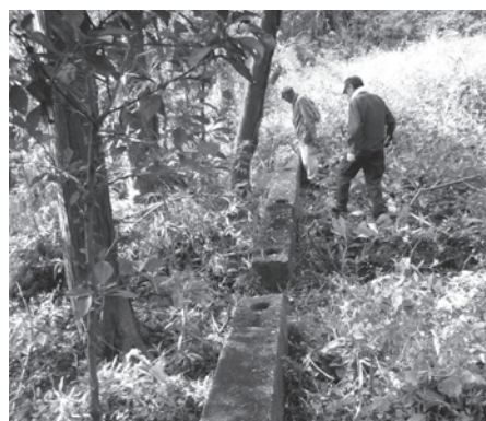
挿写真2 発掘前電源室の様子
