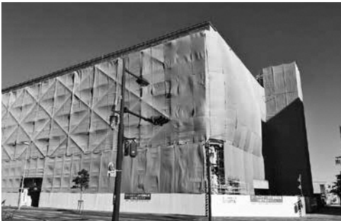
改装工事が進められるぴ〜ファイブ
