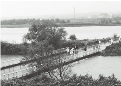
今にも浸水しそうな橋の様子
