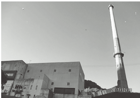
一刻を争う「旧阿知ヶ谷焼却施設」の解体
