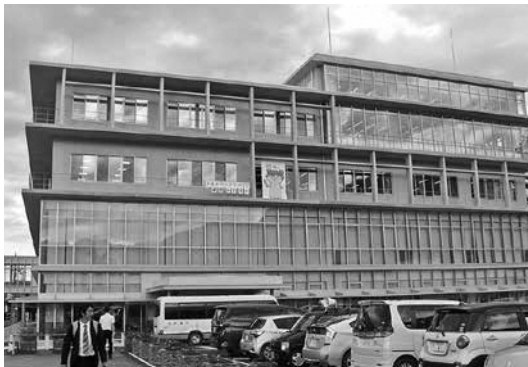
秩父市役所の新庁舎
