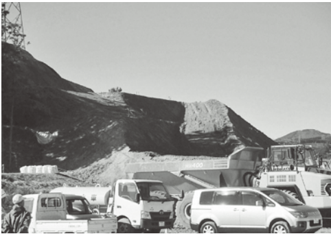
掘削後の牛尾実験所付近（16年12月）
