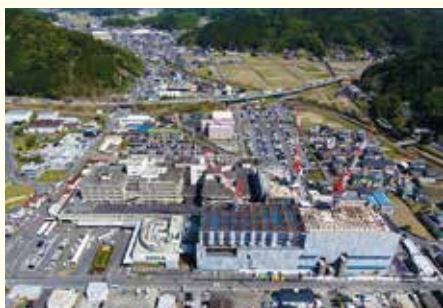
建設中の新病院
