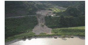
▼令和4年9月台風15号 国道473号道路崩落(福用内)
