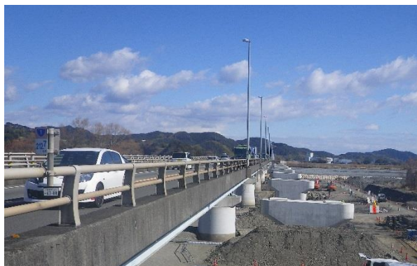
▲国道1号島田金谷バイパス4車線化事業
