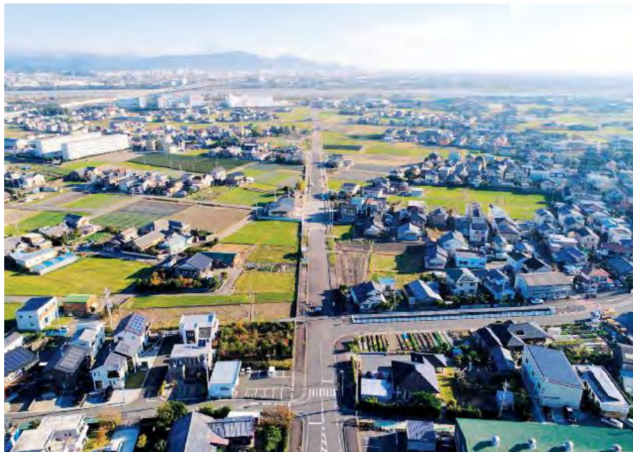
▲ 工事中の色尾大柳線
