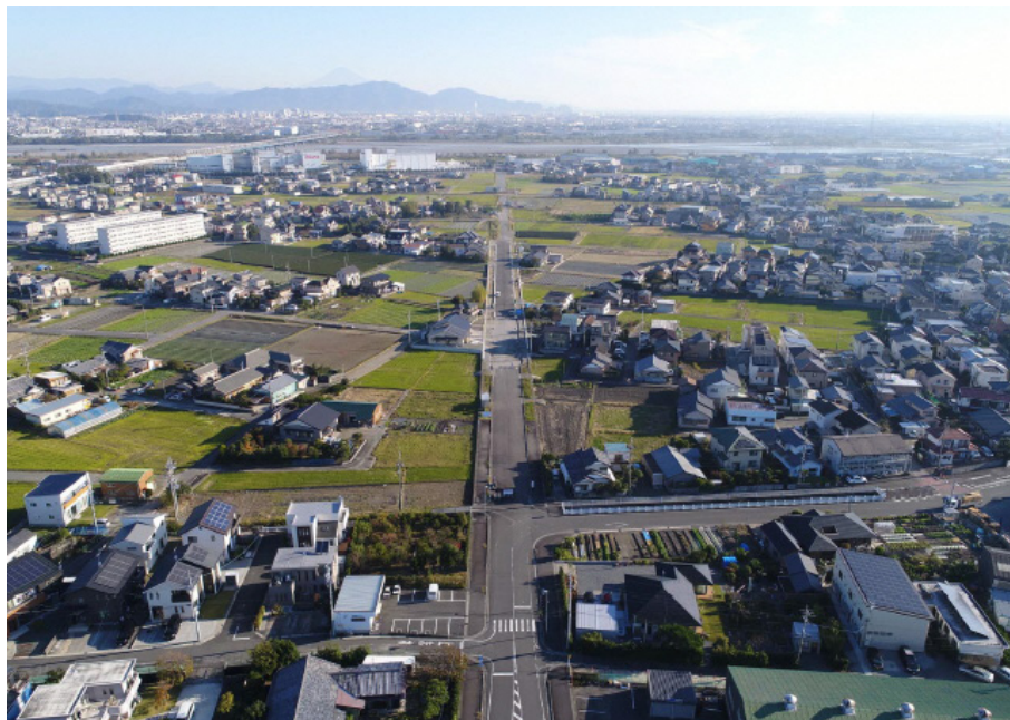
▲ 工事中の色尾大柳線
