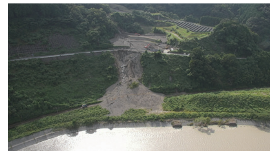
▼ 令和4年9月台風15号 国道473号道路崩落(福用地内)
