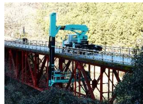
重機による点検
