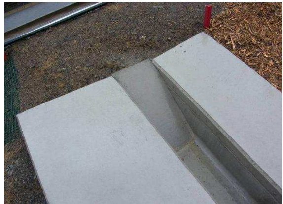
端末を這い出し可能構造とした側溝 動物移動路部 (2012.4.26)
