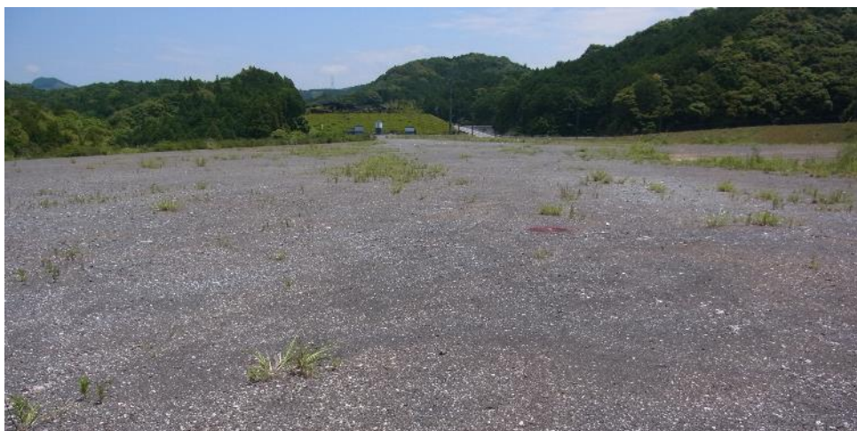
6年前、転圧部はほとんど裸地 2013.6.7
