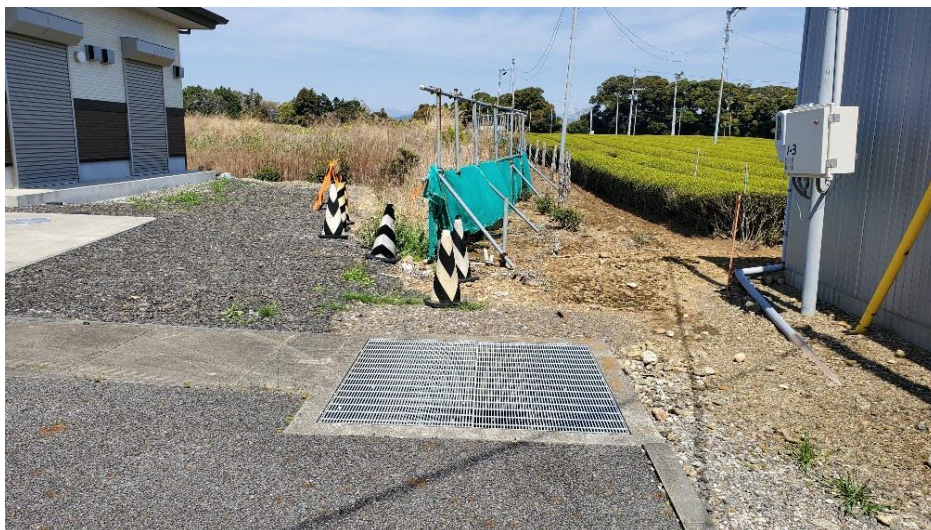
①外周単管柵・シート（対象地東側）
