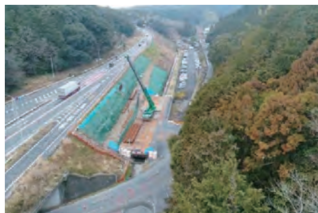
国道1号島田金谷バイパス4車線化工事 (野田インターチェンジ付近、2019年2月)
