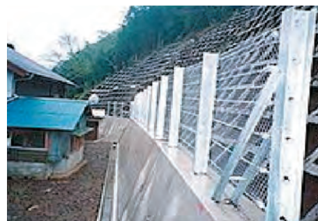
急傾斜地崩壊対策
