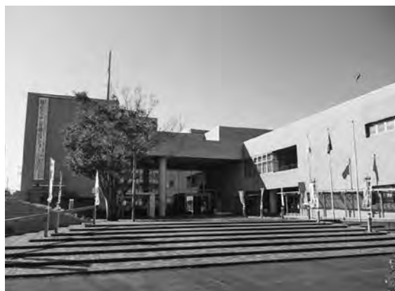
災害ボランティアセンターとなる「おおるり」
