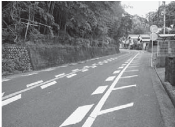
路肩の幅を広くして安全確保 (中央公園道線)
