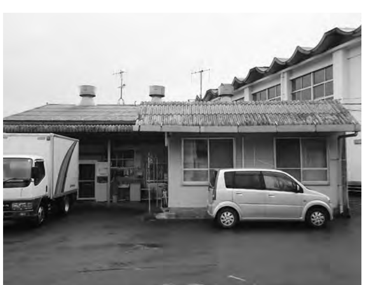
老朽化が進む北部学校給食調理場
