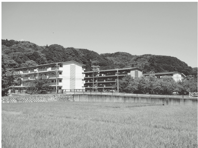
第4期工事を行う予定の大草住宅
