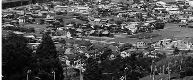
建設中の金谷インターチェンジ
