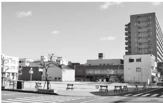
新島田ショッピングビル建設予定地(ビック3丁目店跡地)
