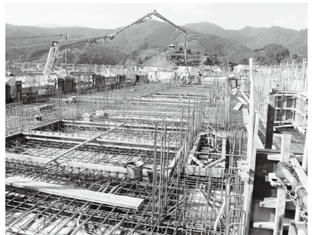
建設中の子育て世代型住宅
