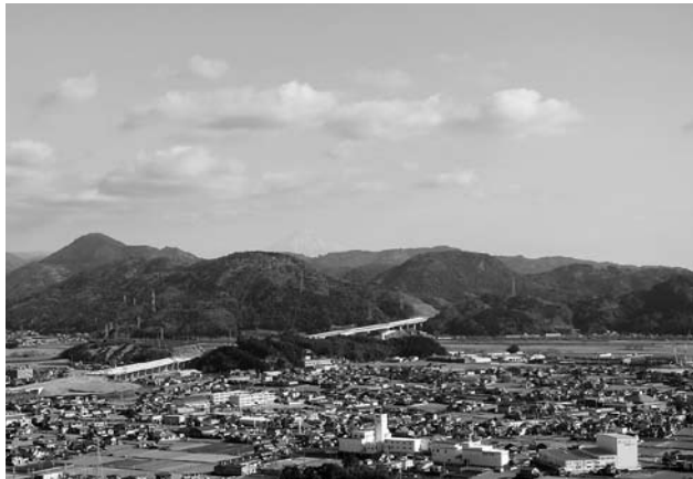
建設が進む新東名高速道路
