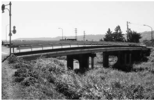
長寿命化修繕策定のための点検
