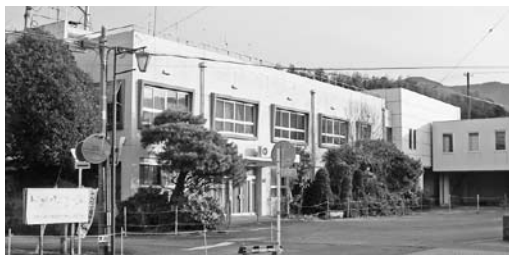
経済危機対策事業により子育て世代型住宅建設地となる旧川根町役場
