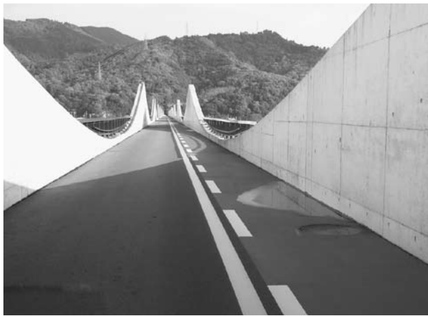
神座と横岡とを結ぶ大井川水路橋
