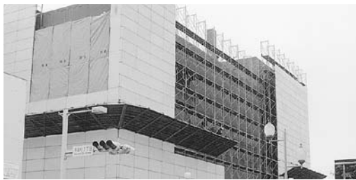
解体が進む新ショッピングビル建設予定地
