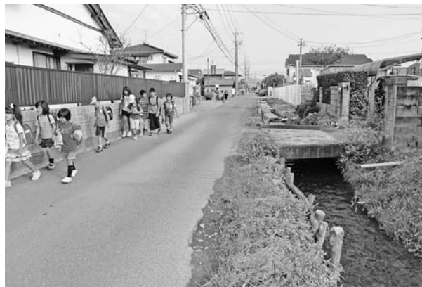
市道谷口大柳線の狭隘箇所
