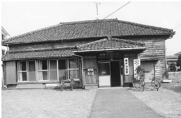
市内の老朽化した某公会堂
