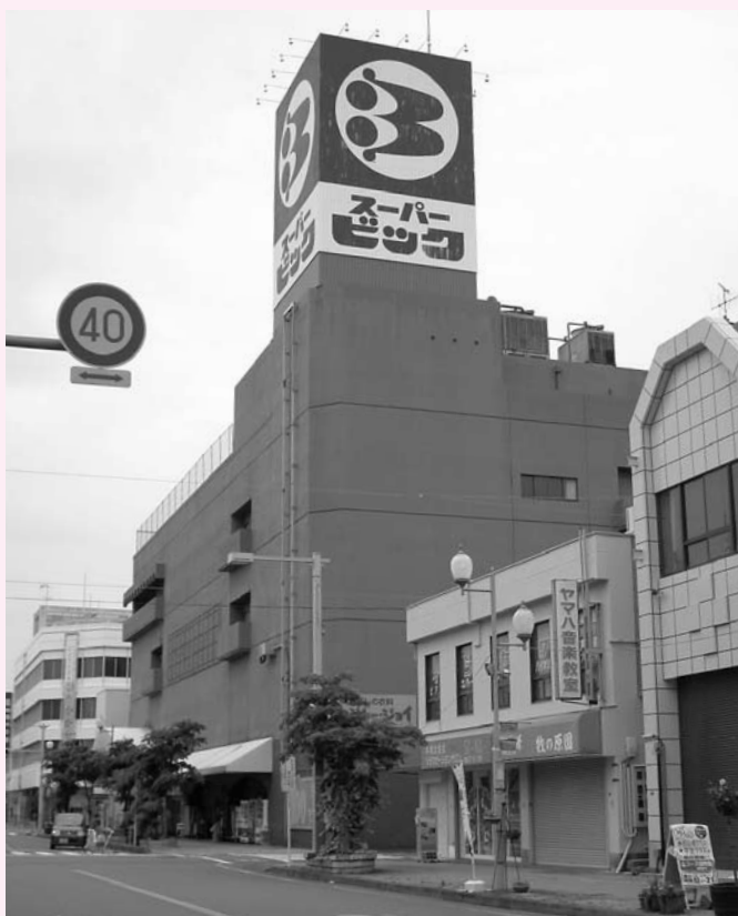
新島田ショッピングビル建設予定地
