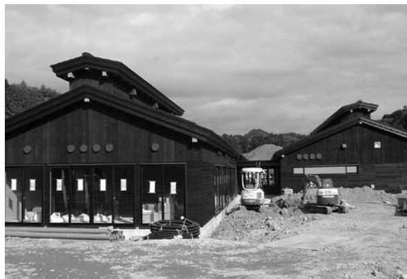
建設が進む田代の郷温泉施設
