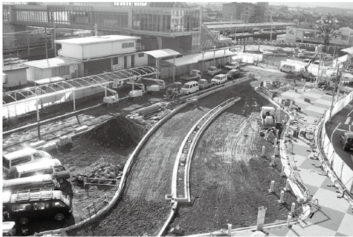
完成が待たれる駅前広場の整備
