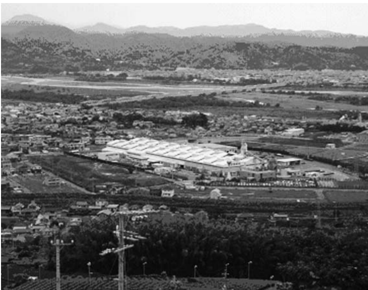
金谷地区往還下の土地区画整理地区
