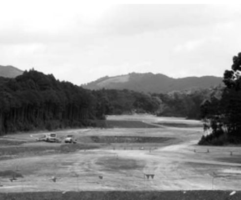
伊太田代の郷 温浴施設建設予定地
