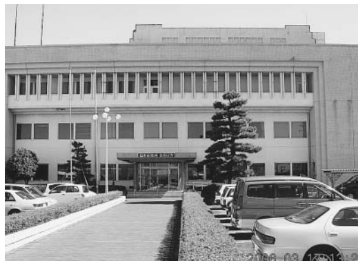
島田市役所 金谷庁舎
