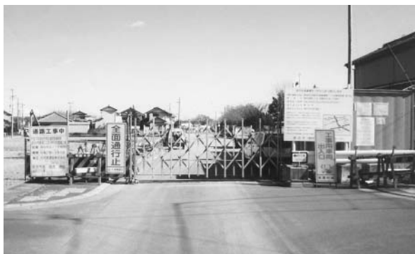
平成19年度開通を目指し工事が進む道悦旭町線
