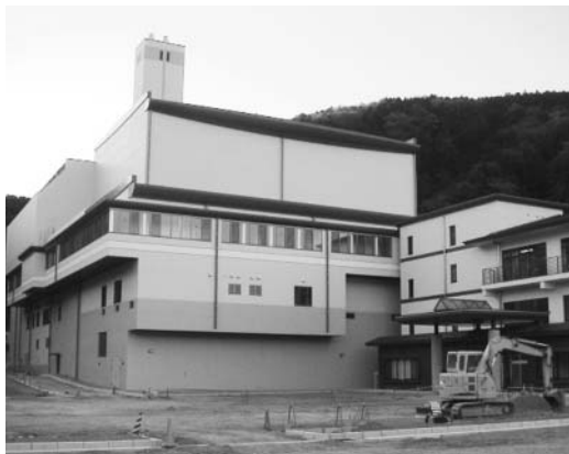
廃プラスチックも処理するとは？ 伊太・田代のガス化溶融炉
