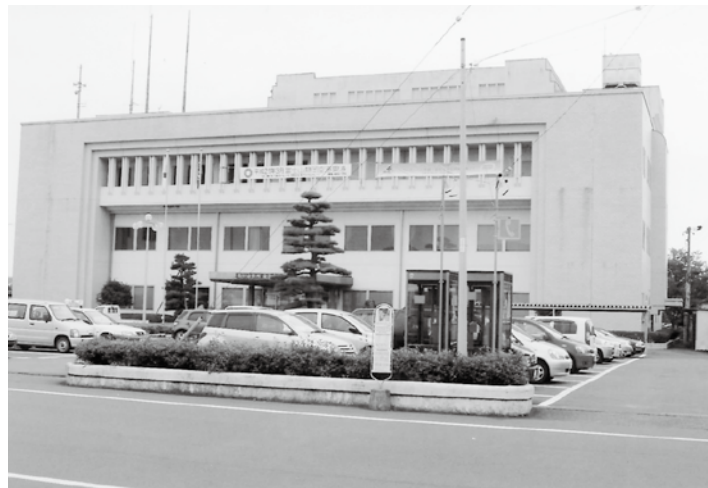
解体が予定されている金谷支所庁舎
