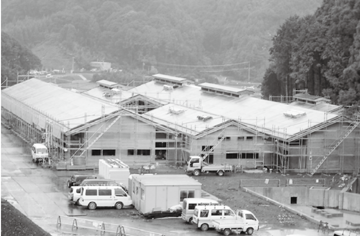
建設中の田代の郷温泉施設
