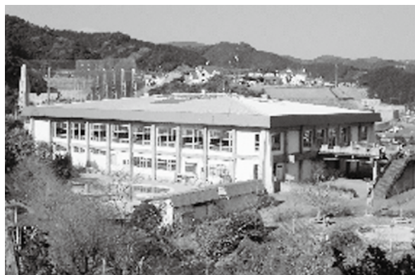
新築により取り壊しが予定される中央体育館
