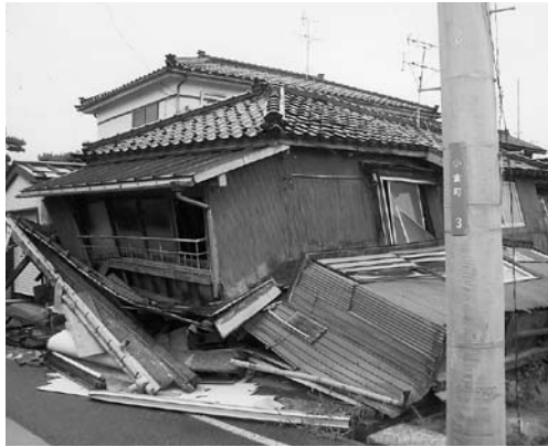
地震対策の強化を！(中越沖地震の被災状況)
