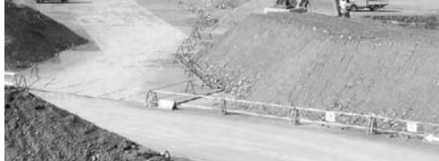
温浴施設等の建設工事が進む田代の郷
