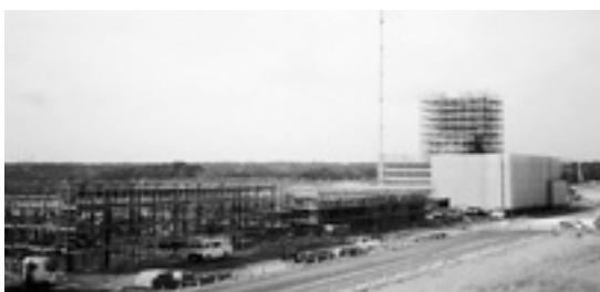
建設中の富士山静岡空港庁舎・管制塔など
