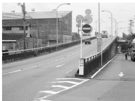
耐震補強が予定される駅西陸橋
