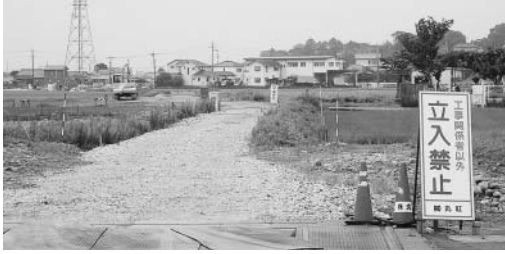
早期完成が待たれる島田吉田線バイパス阪本工区
