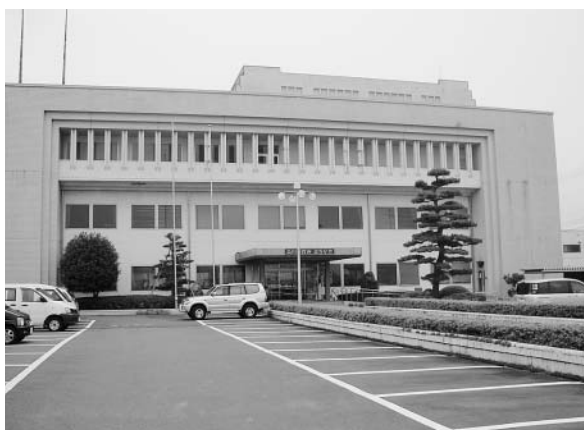
金谷支所庁舎の耐震工事は？
