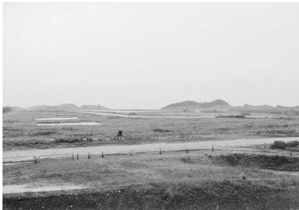
開港を間近に控え整備が進む静岡空港
