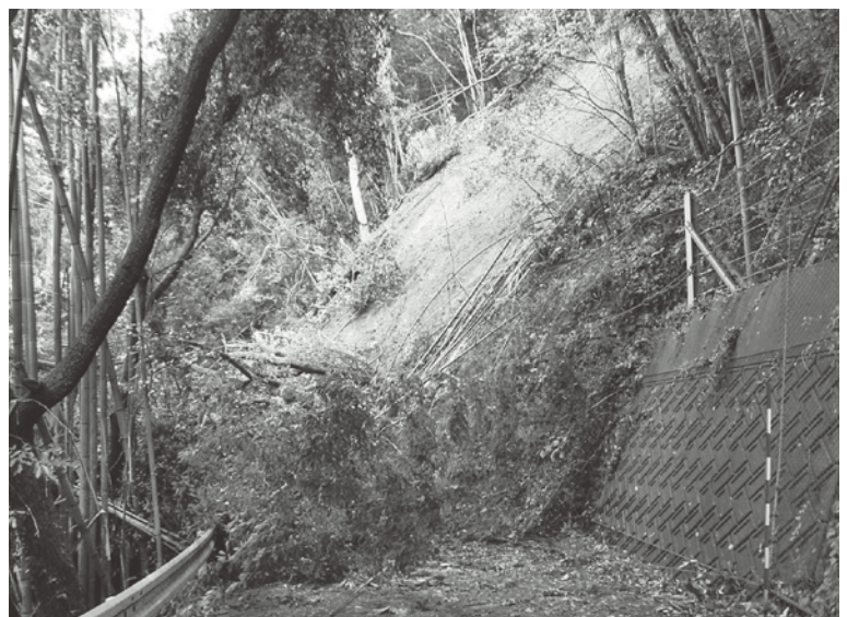
土砂崩れによる市道地蔵峠停車場線の被害の様子 (島田市神尾、平成24年6月撮影)
