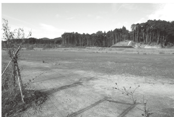
一時中断している田代の郷陸上競技場建設現場
