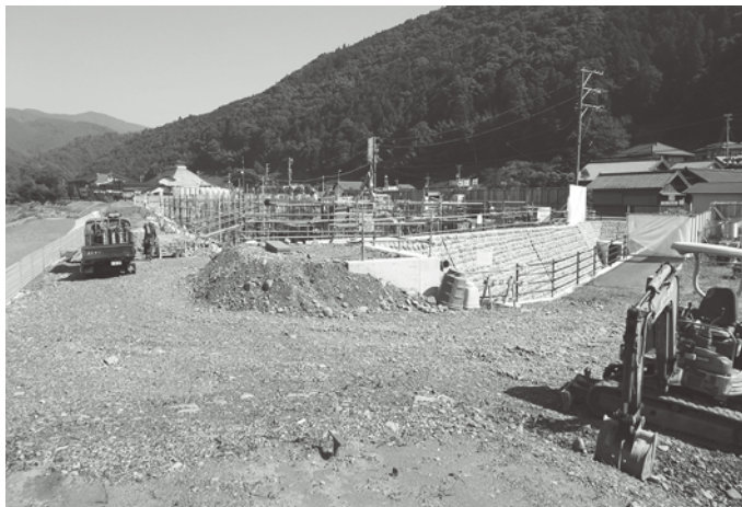
工事中の川根温泉宿泊施設
