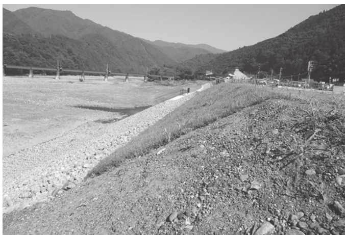
宿泊施設建設に伴う大井川護岸工事
