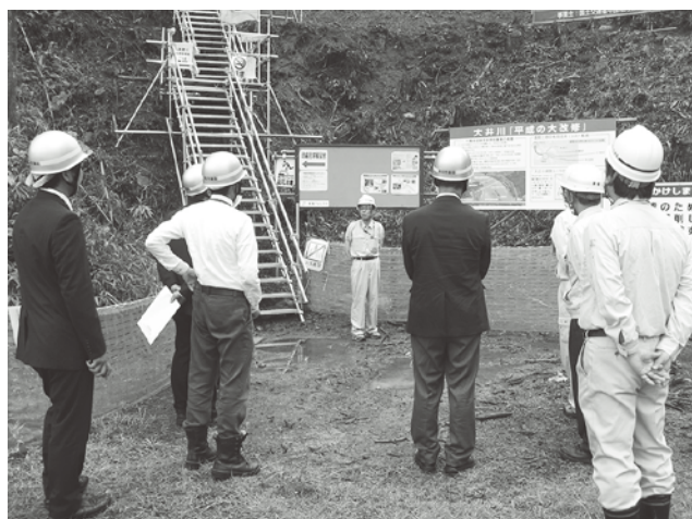
作業員から概要説明を聞く新人議員（牛尾山掘削工事現場）
