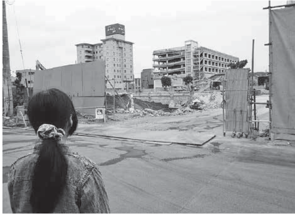
土地所有企業により解体された旧ジャスコ建物
