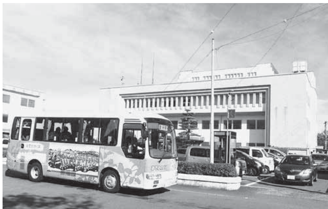
解体が決まっている金谷庁舎とコミバス
