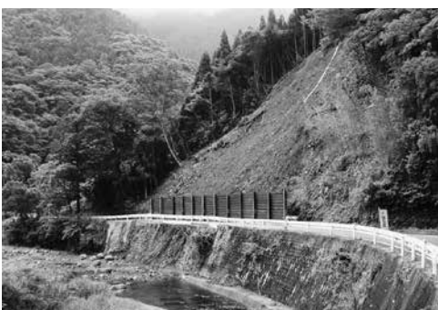
5月に伊久美地区で発生した土砂災害の現場
