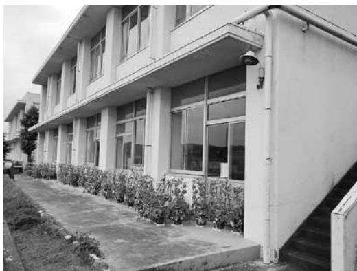
改修予定の初倉南小学校校舎部分(一番手前の教室)
