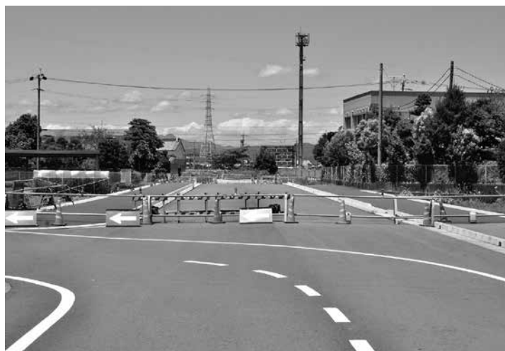
交付金減額の影響は（写真は谷口中河線改良工事）
