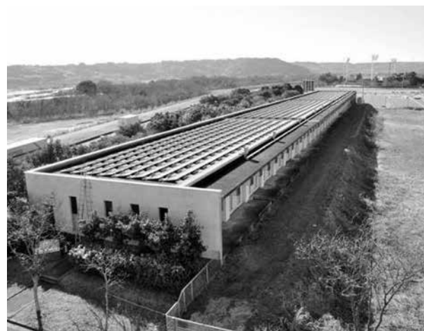
4300世帯が利用する公共下水処理場
