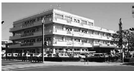
S37年に建築された本庁舎
