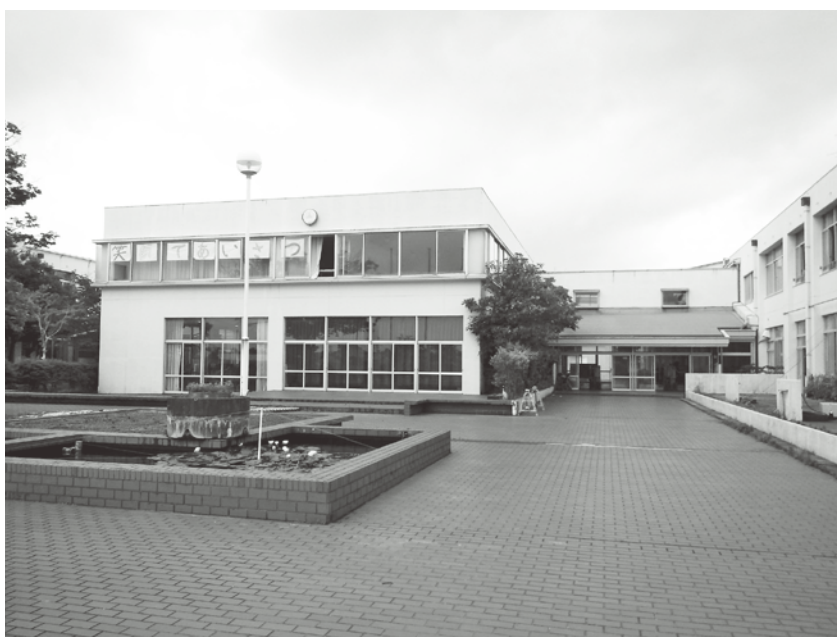
校舎耐震化工事が行なわれている初倉小学校
