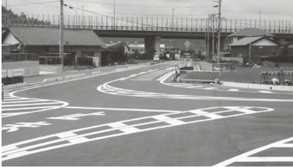
新東名インターチェンジ付近での道路改良（横岡新田）
