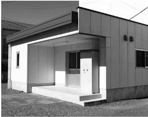
新しくなった川根小学校給食配膳室
