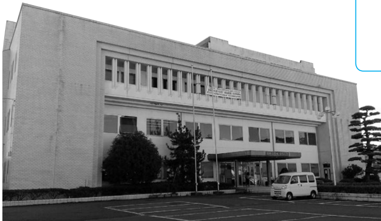
公共施設マネジメントにおいて跡地利用が検討される 金谷庁舎
