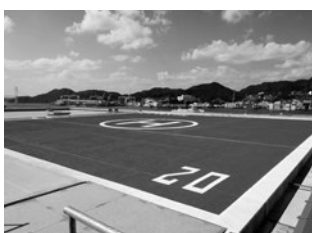
メディカルセンター屋上のヘリポート
