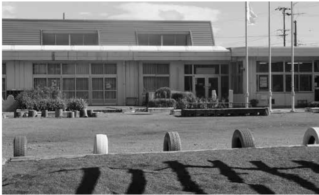
つり天井落下防止工事を行う五和幼稚園
