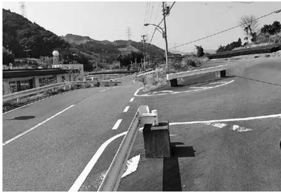
菊川神谷城線の变形したままの道路(神谷城保育園周辺)
