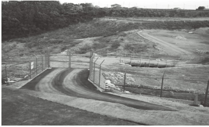
最終処分場に緊急設置した仮設搬入口
