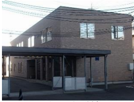
市役所会議棟
